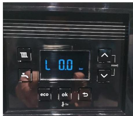
3. Il display mostrato nell'immagine indica che la pressione nel sistema è insufficiente e che è necessario riempirlo.
