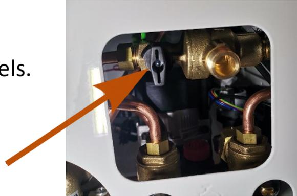
Lassen sie den Hahn geöffnet bis auf der digitalen Druckanzeige 1.5 bar angezeigt werden.
