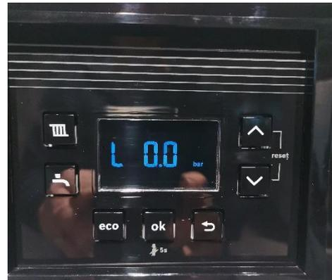
Die im Bild gezeigte Anzeige bedeutet, dass zu wenig Druck in der Anlage ist und Sie sie füllen müssen.
