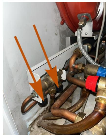
3. Lassen Sie die beiden Dreher geöffnet, bis 3 Striche auf der im Bild markierten Anzeige angezeigt werden.
