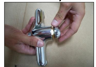
4 - desenroscar el anillo cromado cubierta-tuerca
